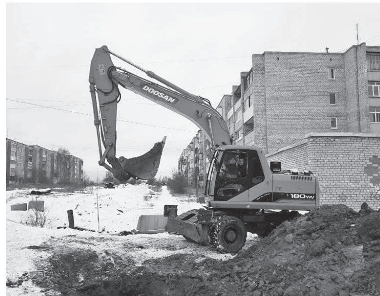
Строители выполняют первый этап работы / Фото: Василий Ергашев, "АР"
