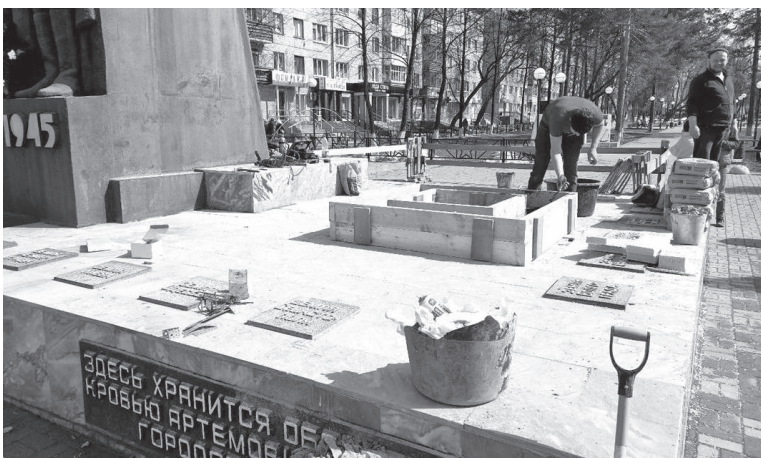
Строители должны закончить все работы и провести пуско-наладку до конца апреля / Фото: Василий ЕРГАШЕВ, "АР"
