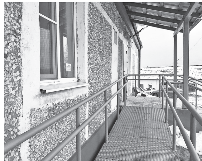
ОВП в Мирново отремонтировали/ Фото: пресс-служба АЦРБ
