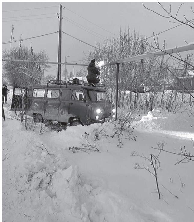
Ведутся ремонтные работы на газопроводе / Фото: предоставлено администрацией АГО
